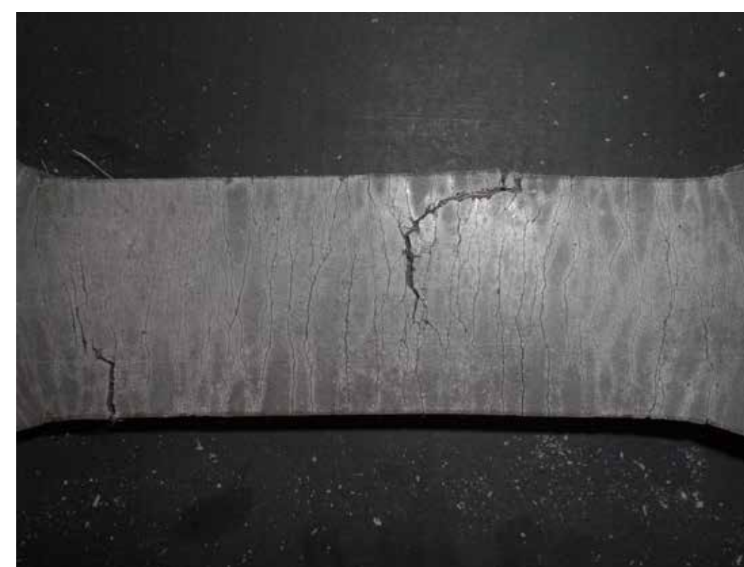
コンクリートに発生するひび割れ
