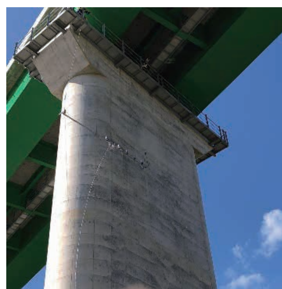
点検システム開発状況2(実地試験)
